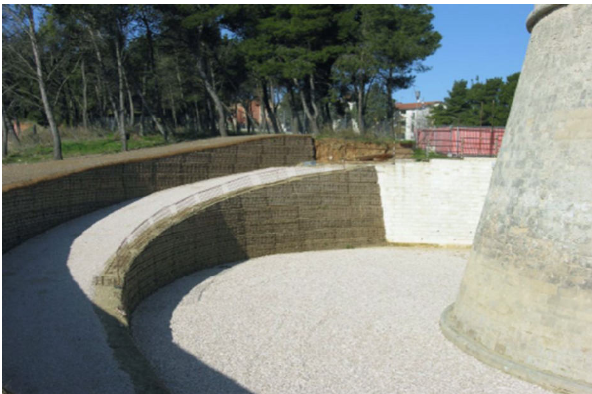
Foto 4 - Rampa di accesso al fossato
